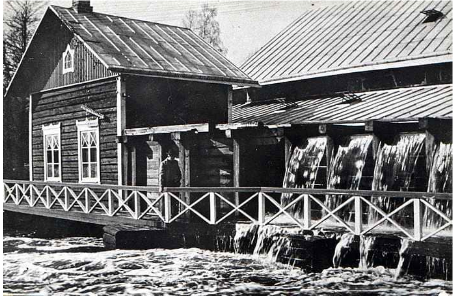
Vuonna 1913 purettu sähkövoimalaitos. SatM.
